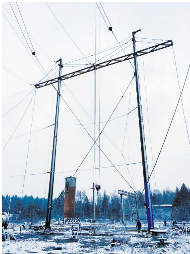
Рис. 2. Общий вид опоры, подготовленной к испытаниям
