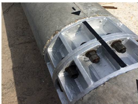
Рис. 1. Внутренний фланец для соединения секций (типовое решение)
