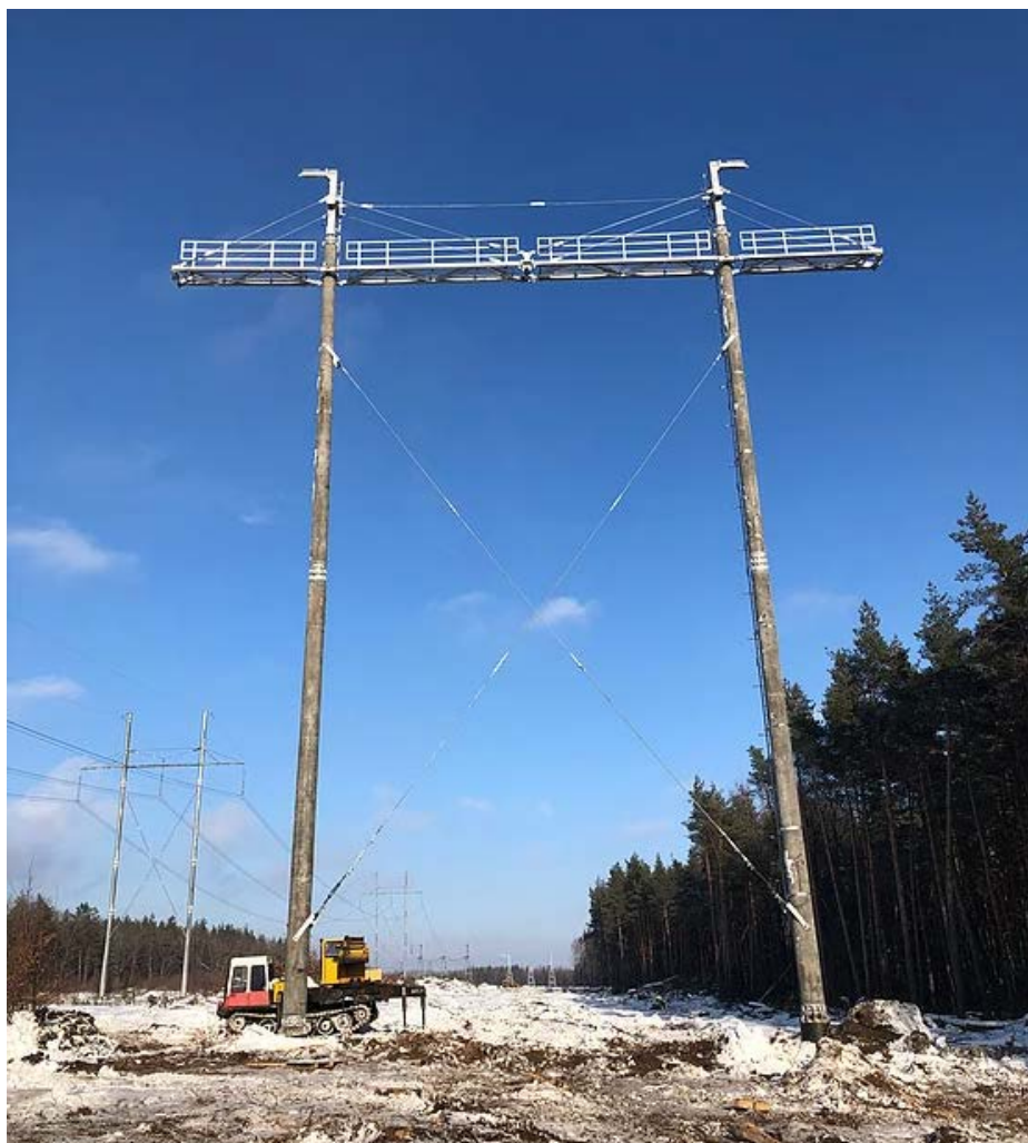
Рис. 3. 2СПБ500-3В на ВЛ 500 кВ «Донская АЭС – Старый Оскол 2»
