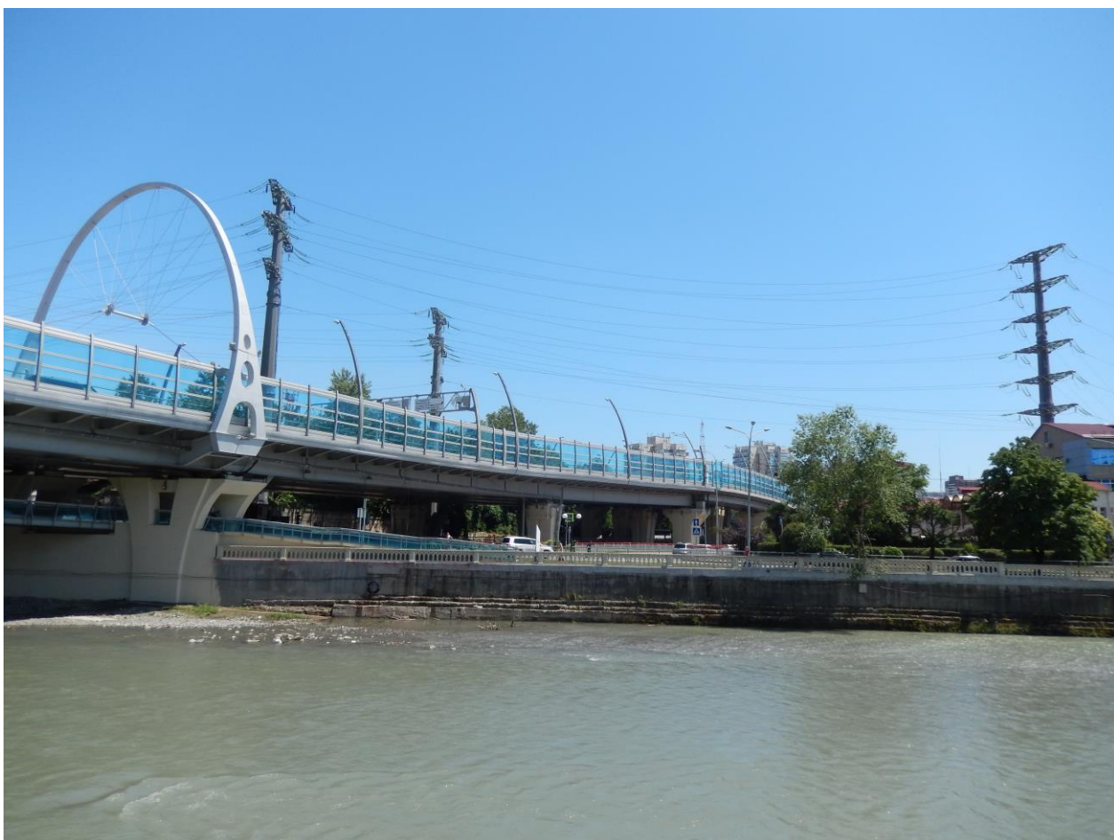
Рис. 1. Четырехцепный захода ВЛ 110 кВ на ПС «Сочи» на модифицированных анкерно-угловых опорах УММ-220-4.2.110.20+6* и УММ220-4.2.110.4В+18 с переходом через авто- и железнодорожный путепровод в г.Сочи (2010-2012 годы)
