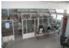
**Статический компенсатор мощности СТАТКОМ  $\pm 50$  Мвар** для Выборгского преобразовательного комплекса, обеспечение реверса электроэнергии с Финляндией (мощность до 320 МВт)
