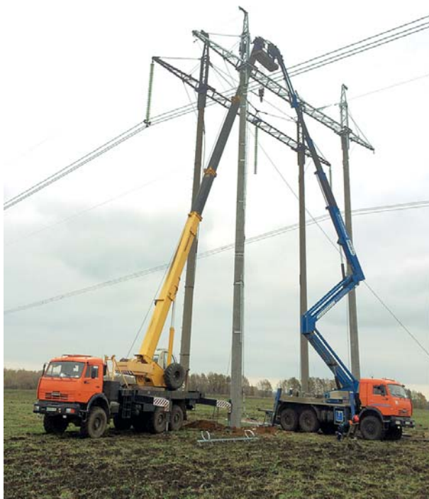
Рис. 1. Замена опоры ПБ500-5н на ПБ500-5н(с) на ВЛ 500 кВ Тамбов — Пенза 2
