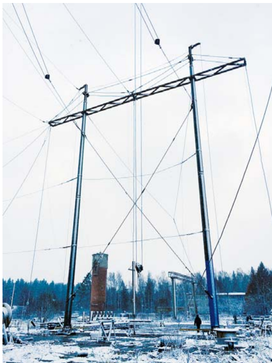
Рис. 3. Общий вид опоры, подготовленной к испытаниям
