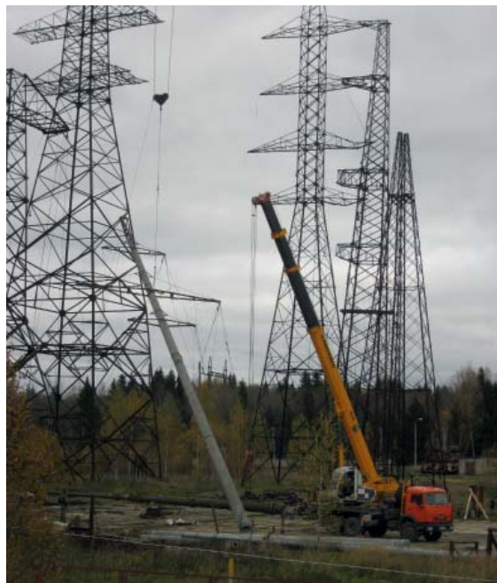
Рис. 5. Монтаж двухцепной промежуточной опоры на испытательном полигоне в г. Хотьково
