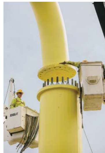
Рабочие направляют изогнутую часть опоры, которая будет поддерживать горизонтальную траверсу на верхушке основной стойки.
