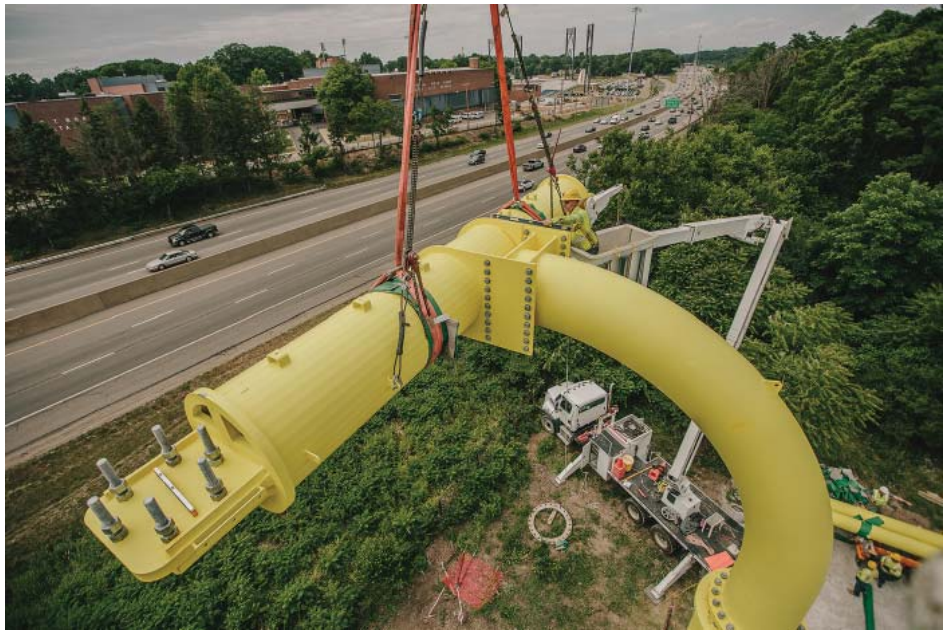
Финальная подгонка траверсы перед отходом подъемника.
