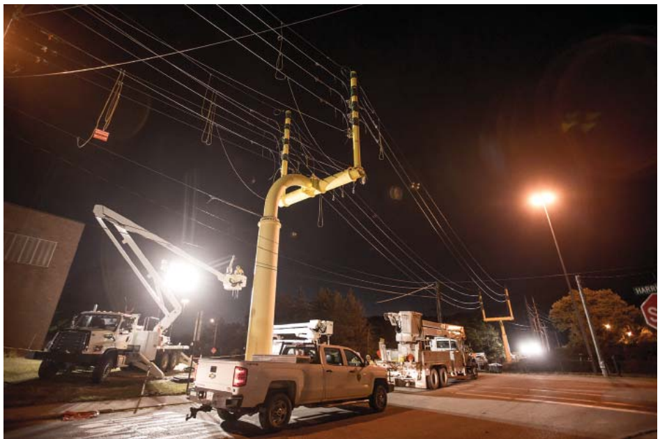
Первая из трех ночей протяжки проводов через федеральную автостраду I-77 завершена. Все провода закреплены и подготовлены к работам следующей ночью.
