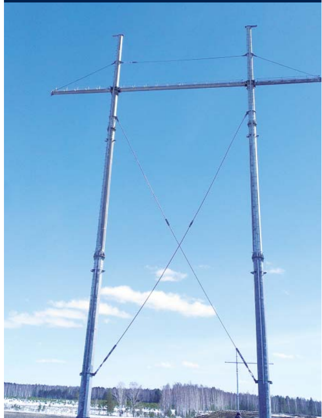
Рис. 1. Двухстоечная промежуточная опора с ветровыми связями 2МП500-1В
