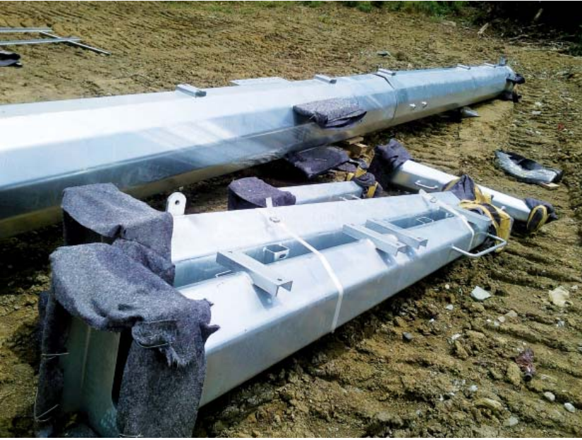
Рис. 2. Многогранная опора, которую доставили на трассу ВЛ 220 кВ СВМ Дзубгинской ТЭС
