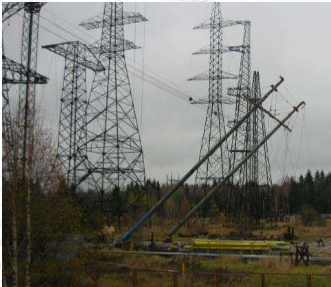
Подъем опоры 2СПБ500-3В
