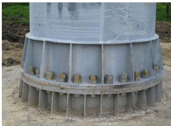
Рис. 2. Фланцевое соединение стальной многогранной опоры с фундаментом
