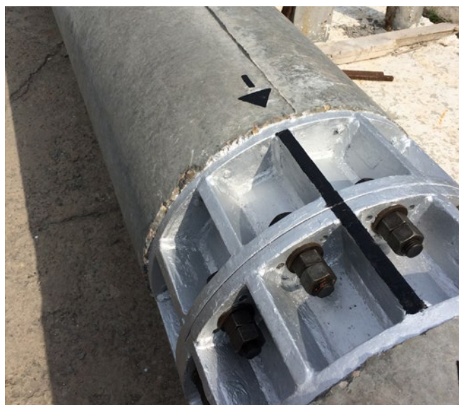
Рис. 3. Фланцевое соединение секций железобетонной центрифугированной секционированной стойки
