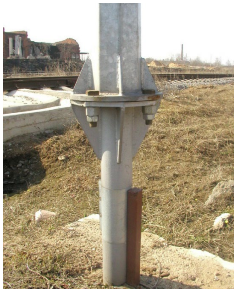
Рис. 5. Фланцевое соединение опоры освещения с фундаментом
