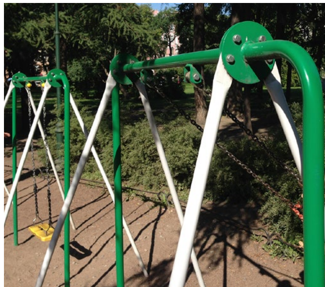
Рис. 6. Фланцевые соединения элементов конструкции детских игровых площадок
