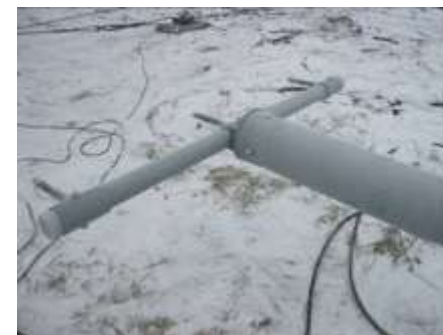
Узел крепления траверсы после испытаний опоры ПК10-2И
