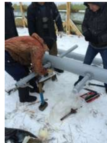
Сборка опоры ПК10-2
