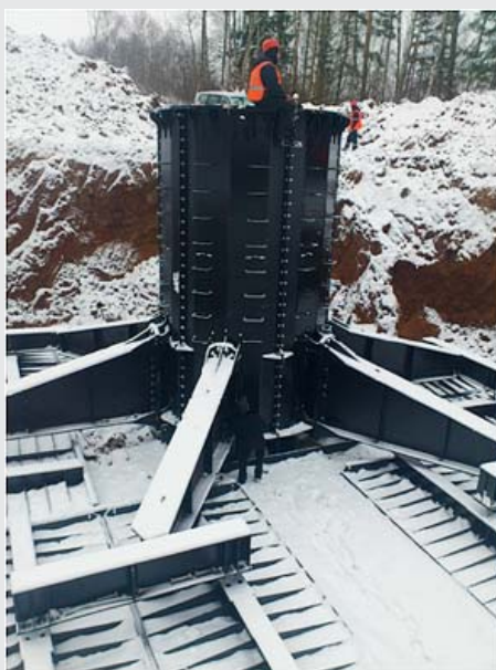
Фундаменты высотных опор ВЛ 220 кВ Черепеть-Орбита-Спутник-Калужская, 2012 г.
