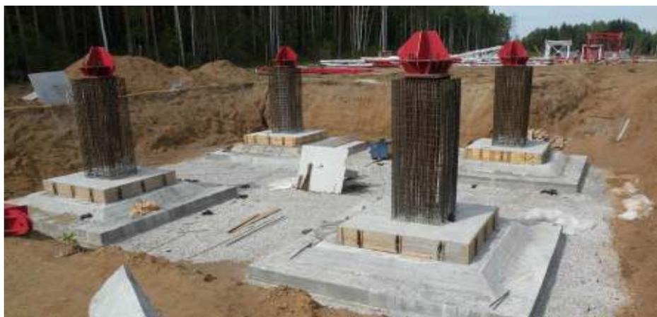
**Рисунок 4.** Монолитный железобетонный фундамент для закрепления опоры перехода ВЛ 220 кВ Пермская ГРЭС – Соболи-1,2 через Камское водохранилище.
