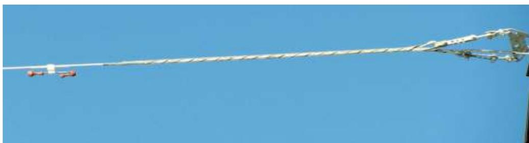
**Рисунок 7.** Смонтированный на концевой опоре натяжной подвес спирального типа с двумя силовыми прядями.
