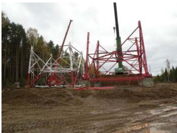
**Рисунок 5.** Монтаж опоры перехода ВЛ 220 кВ Пермская ГРЭС – Соболи-1,2 через Камское водохранилище.
